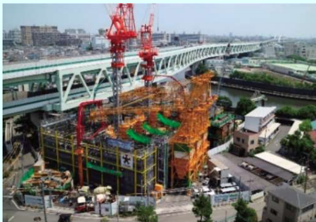
王子第二ポンプ所 (整備中)
