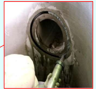
下水道管とマンホールの接続部を対策の様子
