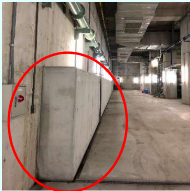
壁の厚みを増して補強することによる施設の耐震化例(両国ポンプ所)
