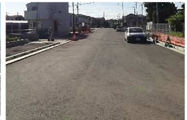
西東京市側から見た 保谷東村山線
