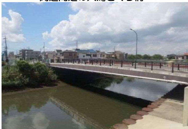
開通間近の大鷲さくら橋
