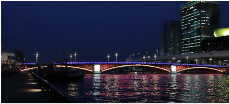
吾妻橋【試験点灯】
