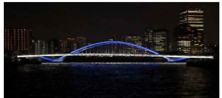
築地大橋【試験点灯】
