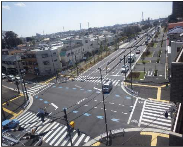
① 塚交差点：4車線交通開放前
