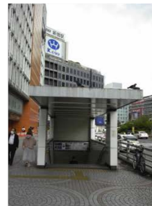
⑱ 1出入口 【地下道出入口】
