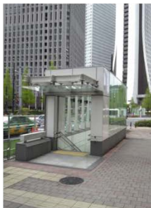
⑬ S2出入口 【地下道出入口】
