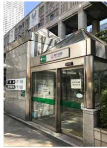
③ 都庁前駅 A4 (エレベータ) 【地下鉄出入口】
