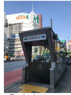
⑤ 新宿西口 D4 【地下鉄出入口】
