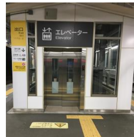
【駅構内のエレベーター】
