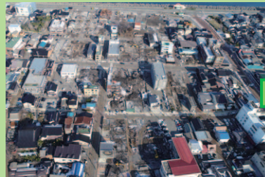
大火から55日後の様子 (地上ガレキ撤去)
