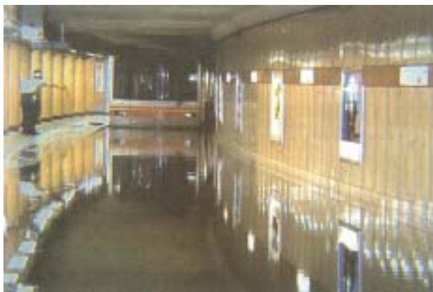
平成 5 年 8 月 27 日台風 11 号による赤坂見附駅への浸水
