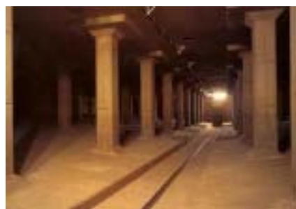
写真 4-5 下水道の貯留施設（調整池）
