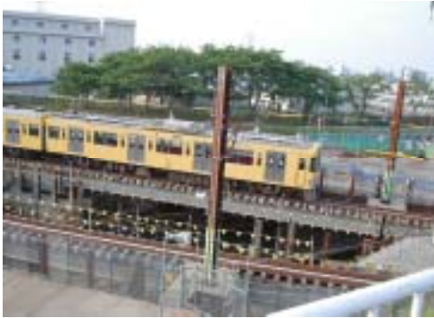
写真 4-3 河川整備(空堀川)に伴う 鉄道橋の架け替え(東村山市富士見町)
