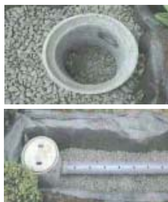
写真 2-1 浸透ますと浸透トレンチ
