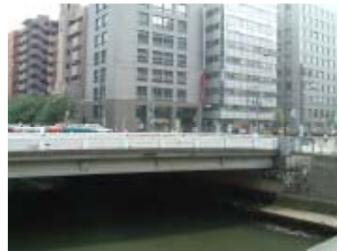
写真 4-4 橋梁の架け替えが必要な 目黒川に架かる五反田大橋(国道1号)
