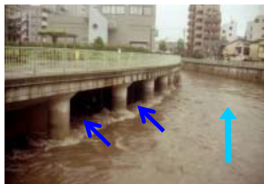
写真 4-2 環七調節池への取水状況
